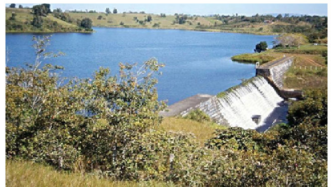
Figura 1. Reservatório da Barragem do Rio da Dona, INFOSAJ (2020)
